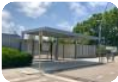
Instal.lació d'una cobertura a l'entrada principal de l'Escola Vall d'Aro
